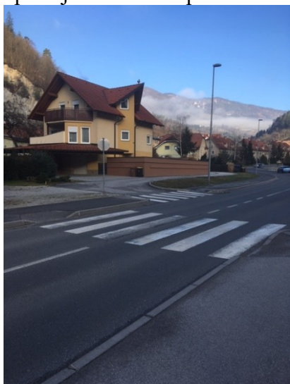
slika 5: urejen prehod za pešce pri Klečki
